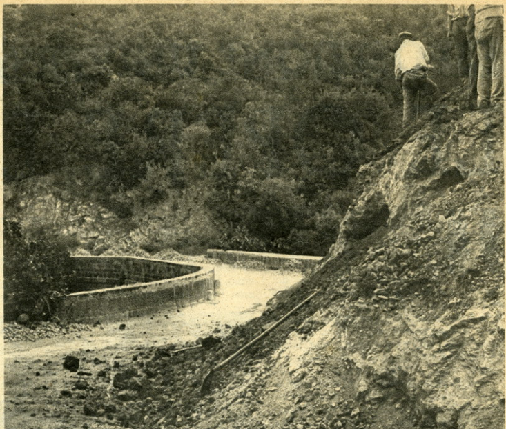
Il più pittoresco circuito d'Italia ha necessità di consentire le più alte velocità. Crollano sotto l'azione del piccone e delle mine le curve naturali...
